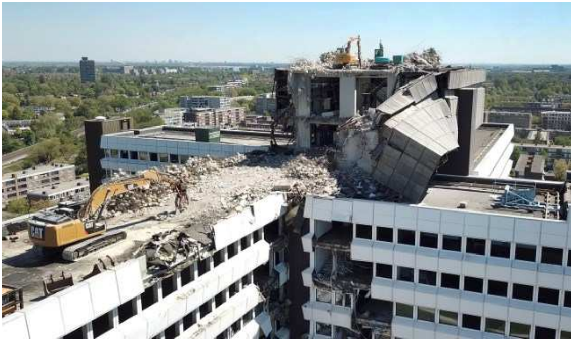
Het CBS-gebouw wordt duurzaam ontmanteld (foto: Michel Groen).
