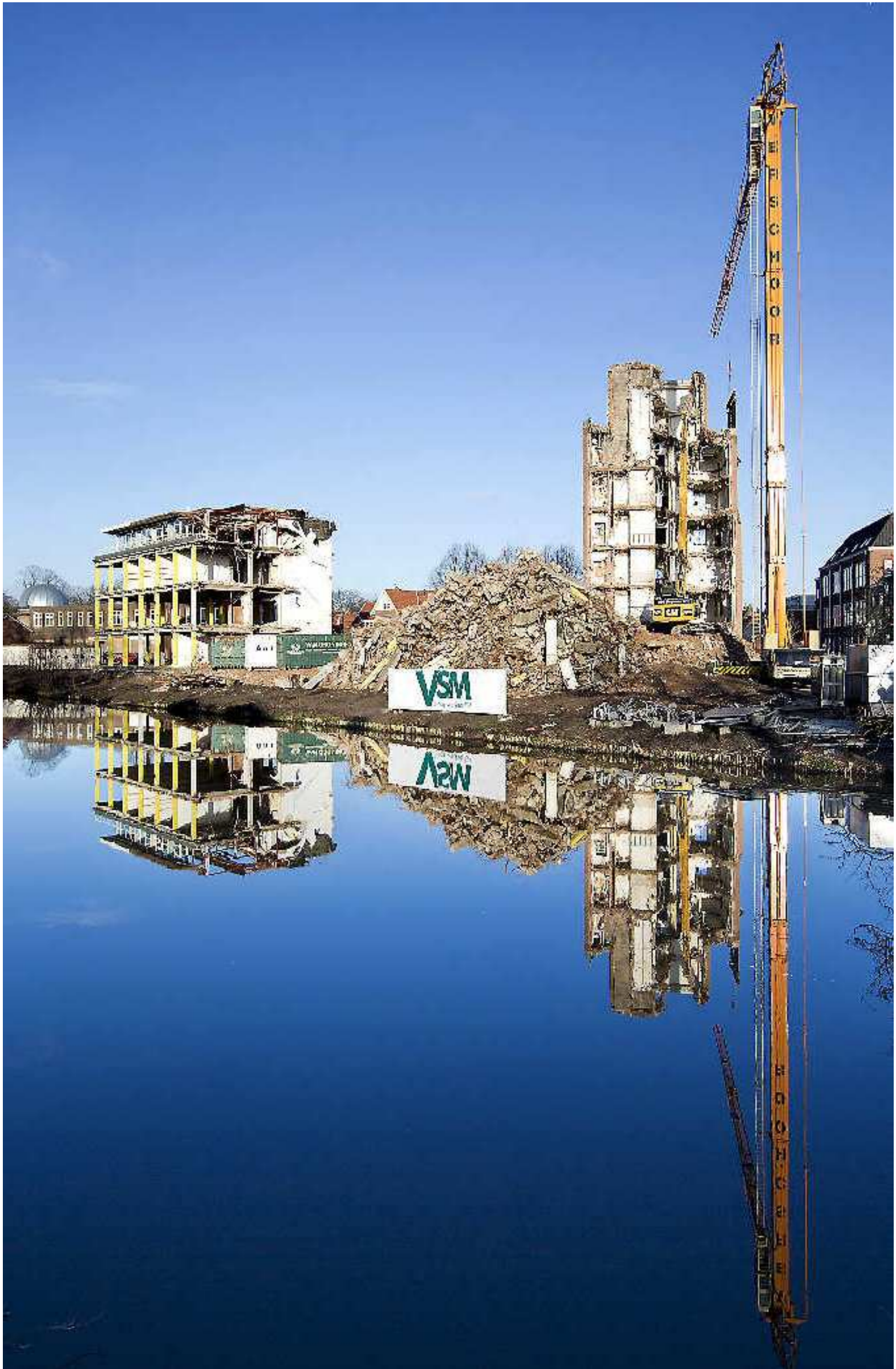
Knipperdeknip, een reusachtige betonschaar haalt steeds een klein stukje af van de Van der Klaauwtoren. FOTO HIELCO KUIPERS
